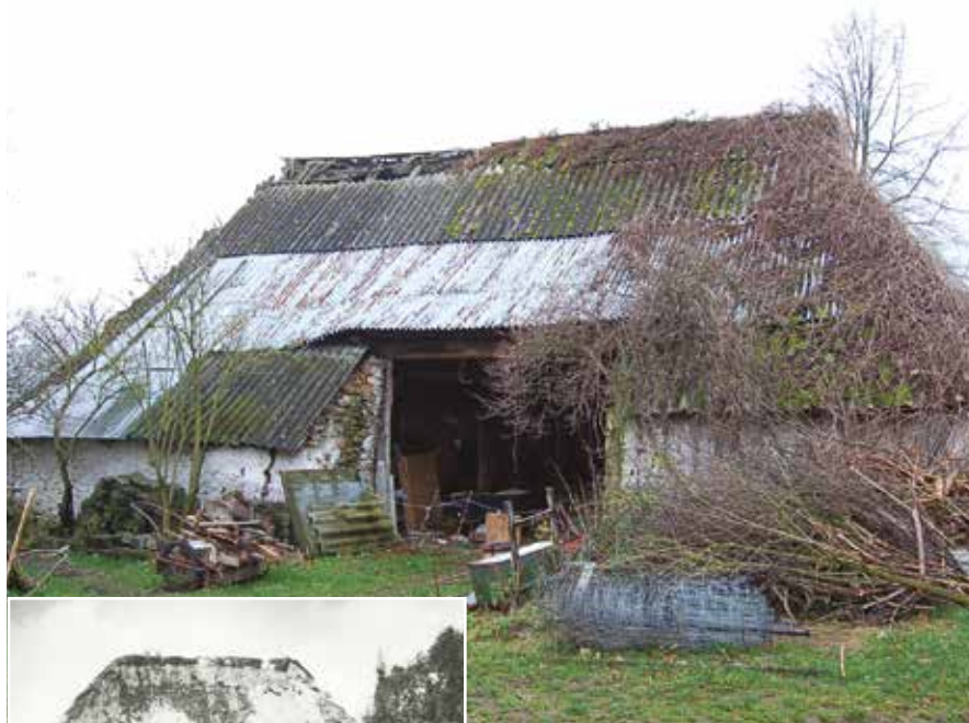
Pro srovnání jedna z mnoha zaniklých stodol na Horažďovicku datovaná rokem 1792 identické rámové konstrukce s kamennou obvodovou zdí a s dochovanou tradiční doškovou krytinou z usedlosti čp. 21 ve Velkém Boru, zanikla i přesto, že byla památkově chráněna. Foto archiv VMH
