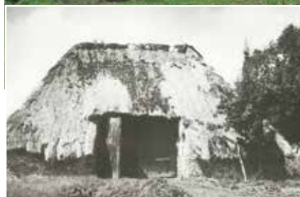
Pro srovnání jedna z mnoha zaniklých stodol na Horažďovicku datovaná rokem 1792 identické rámové konstrukce s kamennou obvodovou zdí a s dochovanou tradiční doškovou krytinou z usedlosti čp. 21 ve Velkém Boru, zanikla i přesto, že byla památkově chráněna. Foto archiv VMH
