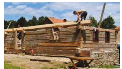
Studenti a brigádníci spolupracující při rekonstrukci roubené chalupy (původně hájovny) z Těšetin. ... a na spodním snímku výsledek jejich snažení. Foto autor
