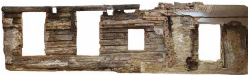
Ukázka jednoho z výstupů dokumentace přenášené stavby: fotogrammetrické plány roubených stěn středověkého domu Mirkovice čp. 1 - interiér. Vypracoval Petr Mudra.
